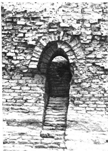
Рис. 20. Помещение 5В. Сводчатое перекрытие прохода
