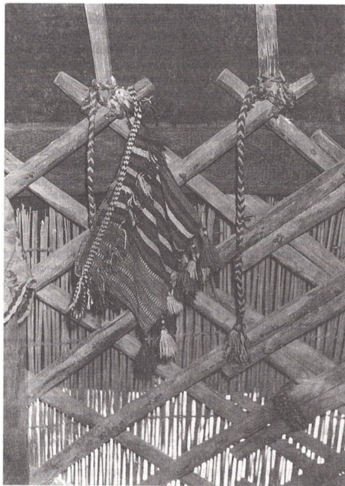
Рис. 1. Скрепление купольных жердей с решеткой юрты. Кишлак Хатак Шерабадского р-на Сурхандарьинской обл. Узбекистана. 1961 г.
