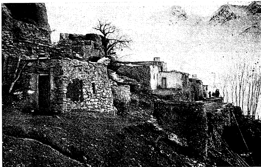
Рис. 6. Жилые и хозяйственные постройки, сооруженные из сланцевого камня в кишлаке Кули-Дахана. Ягноб, 1966 г.
