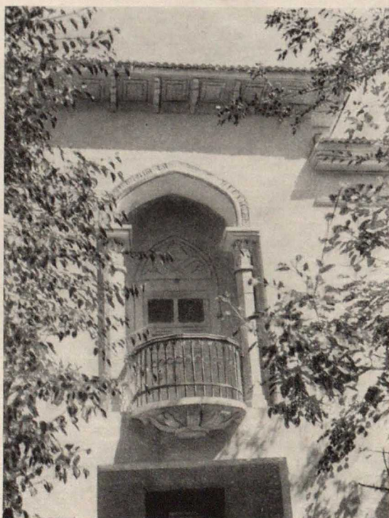
12-квартирный жилой дом. Фрагмент. Авторы — архитектор И. Рачинская и инженер В. Озеров
