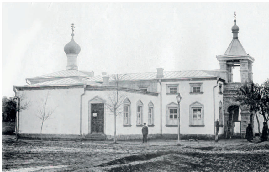
Полторацк. Церковь-школа Св. Креста на углу проспекта Свободы и Гоголевской ул. 1920-е гг. Из архива А. О. Сопиева
