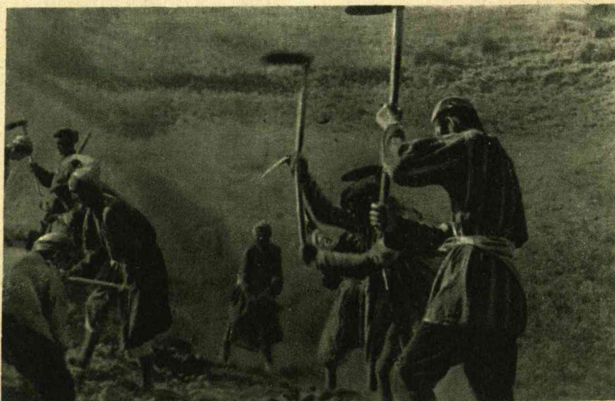
Колхозники Варзобского района строят дорогу в свой дом отдыха
