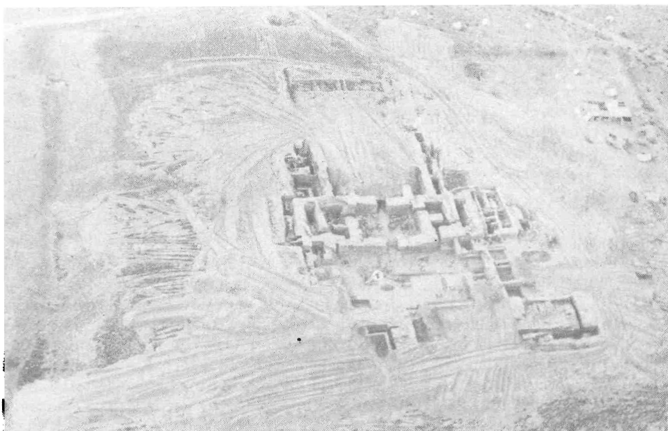
Рис. 2. Храм Окса после засыпки центрального зала и обводных коридоров. Вид сверху. Фото И.Р. Пичикьяна
