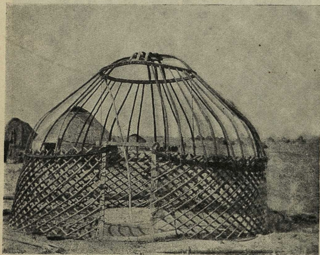
Деревянный каркас юрты Carcasse en bois d'une jurta (tente) Holzgerippe eines Nomadenzeltes
