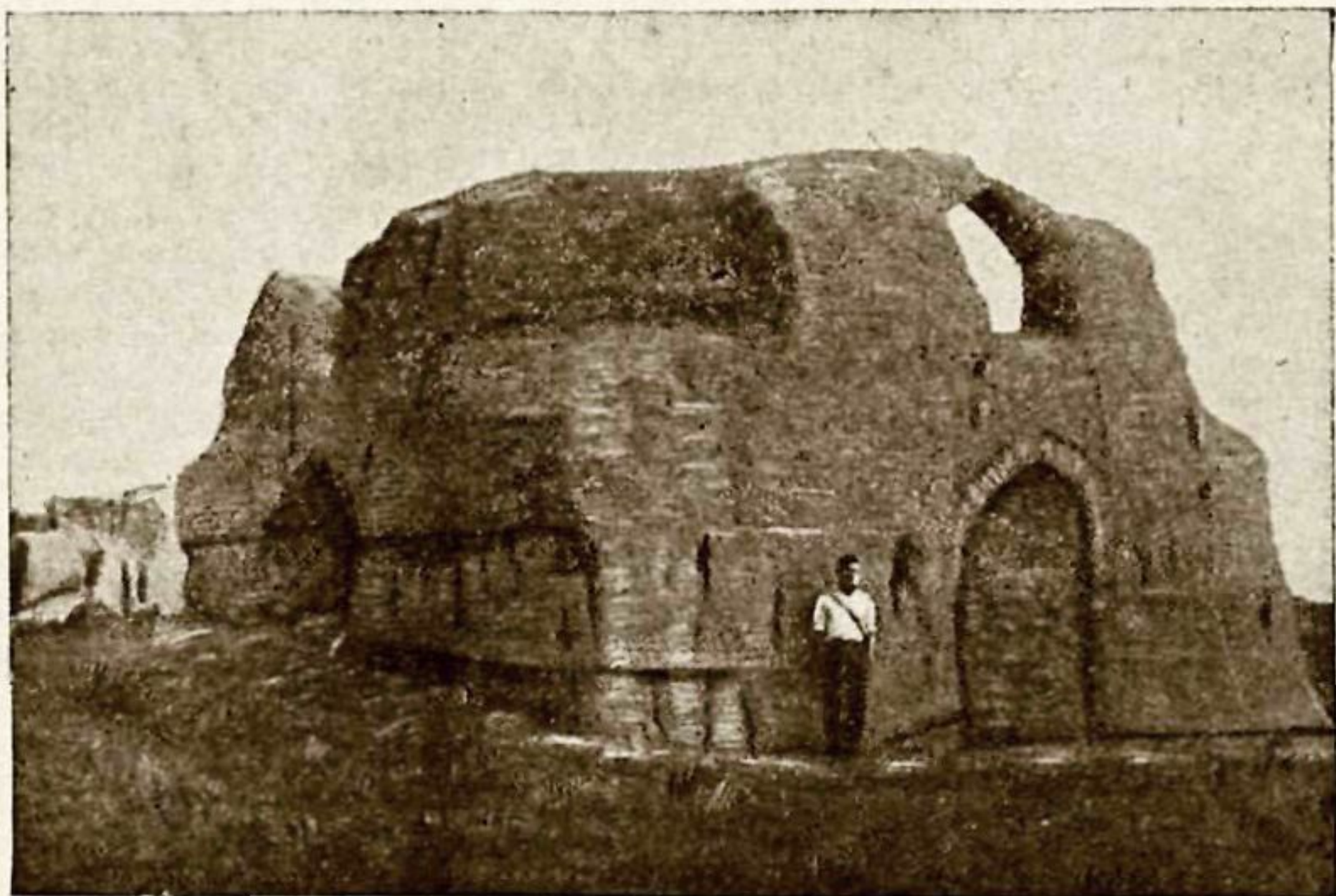
Рис. 35. Наружный вид одного из сырцовых зданий; ясно видны срезы перекрытия в углах.
