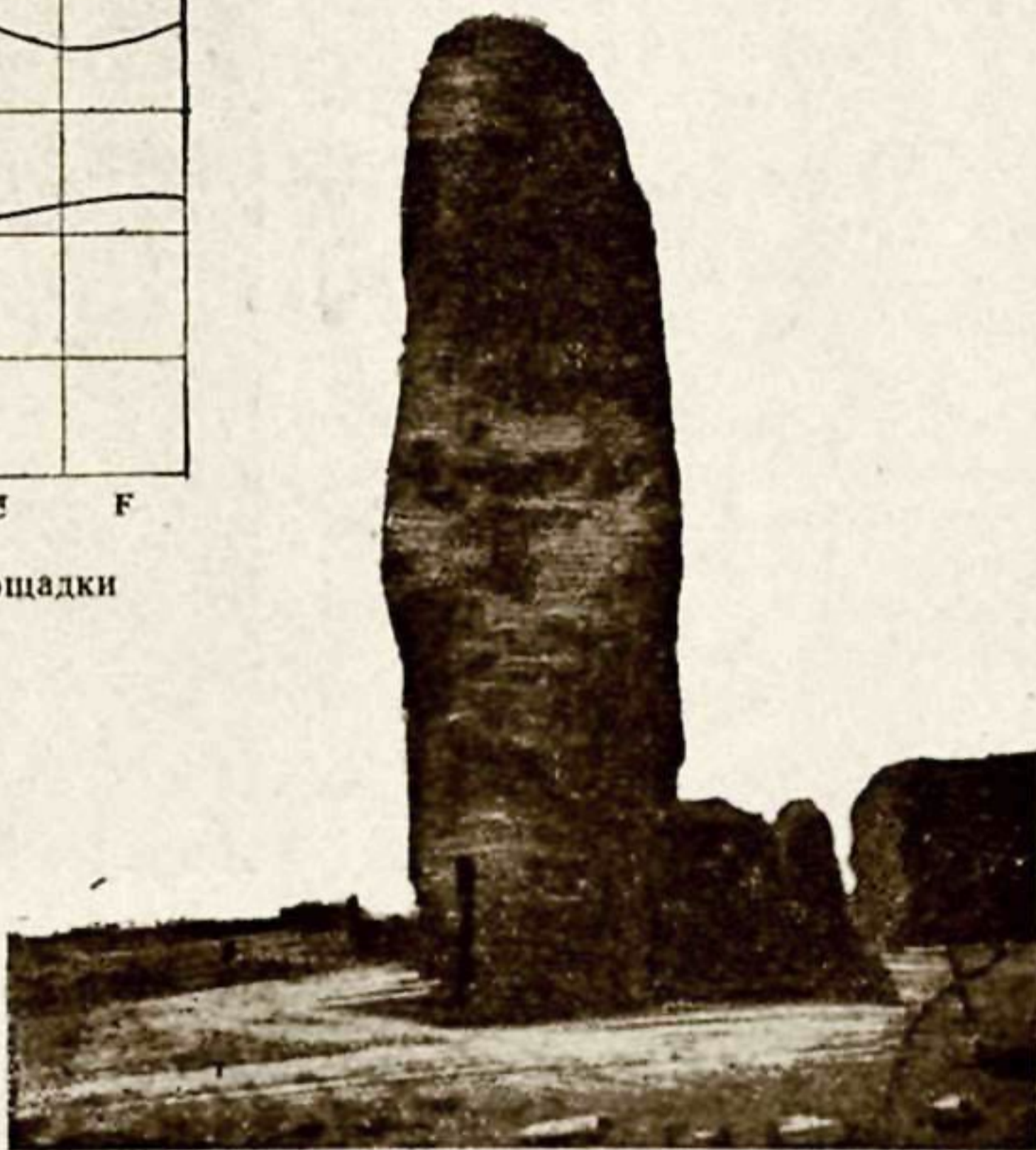
Рис. 25. Остаток северной стены здания № 2; вид с В.
