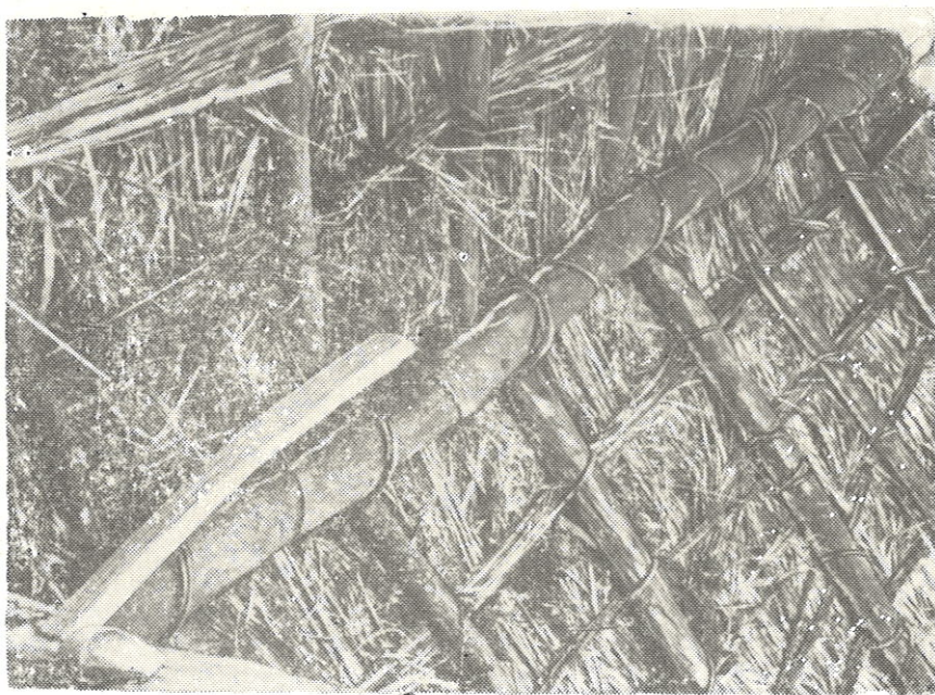
Рис. 2. Крыша-потолок; продольные слуги заменены пучками тростника; видно скрепление поперечных жердей к продольной балке с помощью крученных фисташковых прутьев. Кишлак Уразбай Даганакиинкского района. 1953 г. Фото Н. В. Темнова
