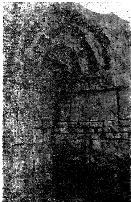
Рис. 6. Фрагмент стены в помещении с куполом.
