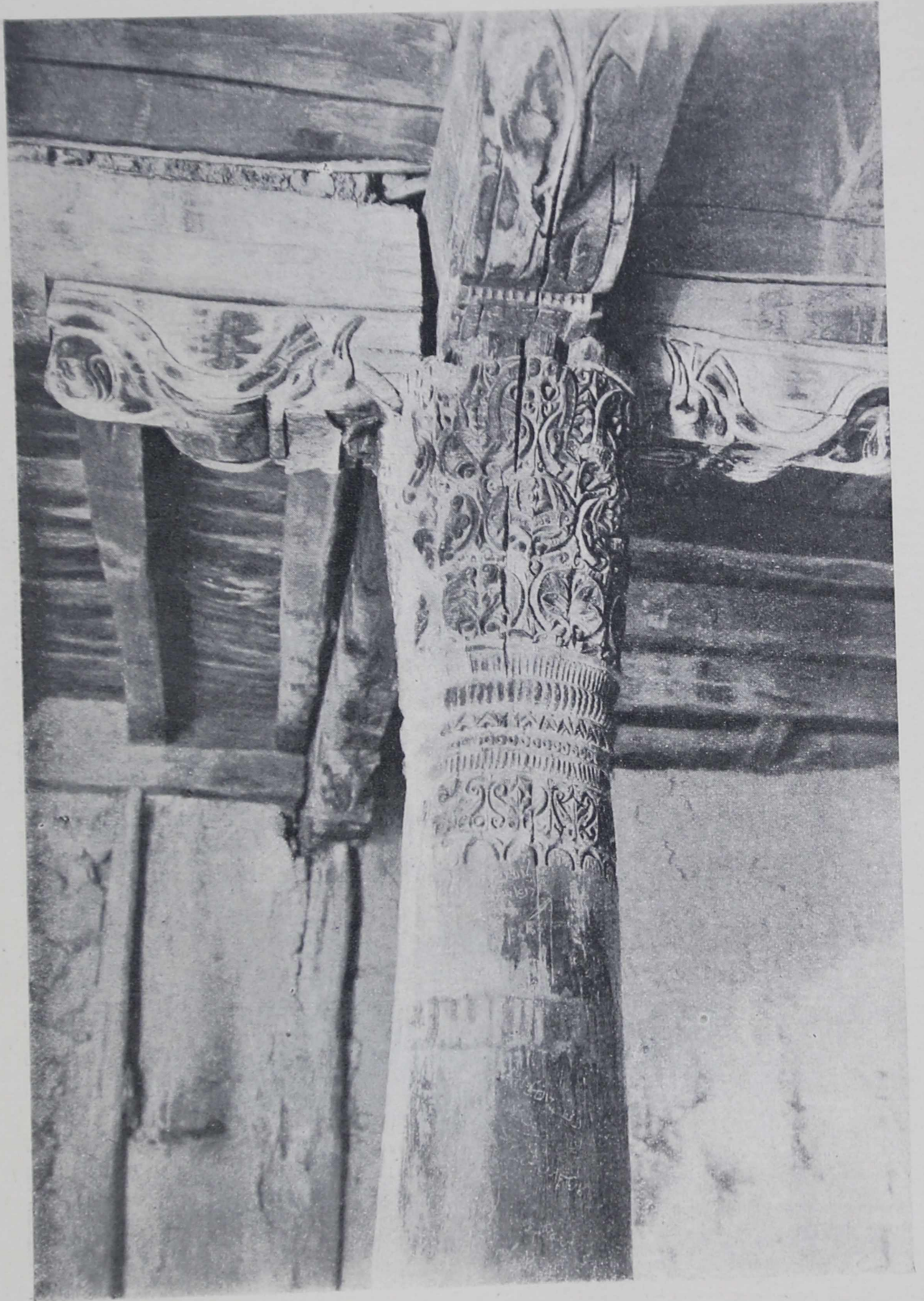
Деревянная колонна в Матче.
