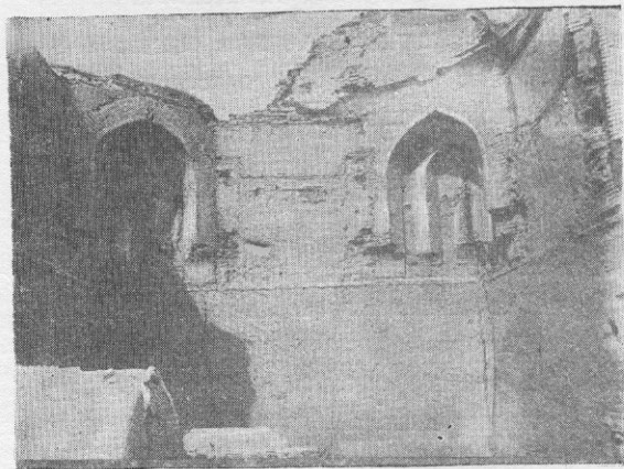
22-в. Перспективный парус здания в Миздахкане.
