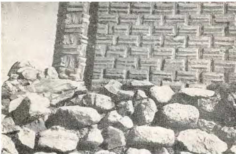
Рис. 8. Араб-ата. Фактурная кладка на восточном фасаде
