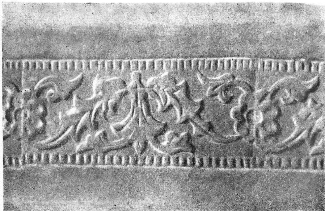
Рис. 53. Узор, оттиснутый штампом по тузгоковой штукатурке, на стене комнаты середины XIX в. в доме Шамсиддина Тураева в гузаре 1-й Мулиён.
