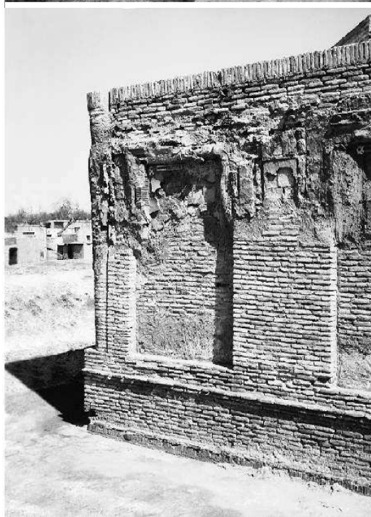
Западная часть. Partie ouest. Western part.
