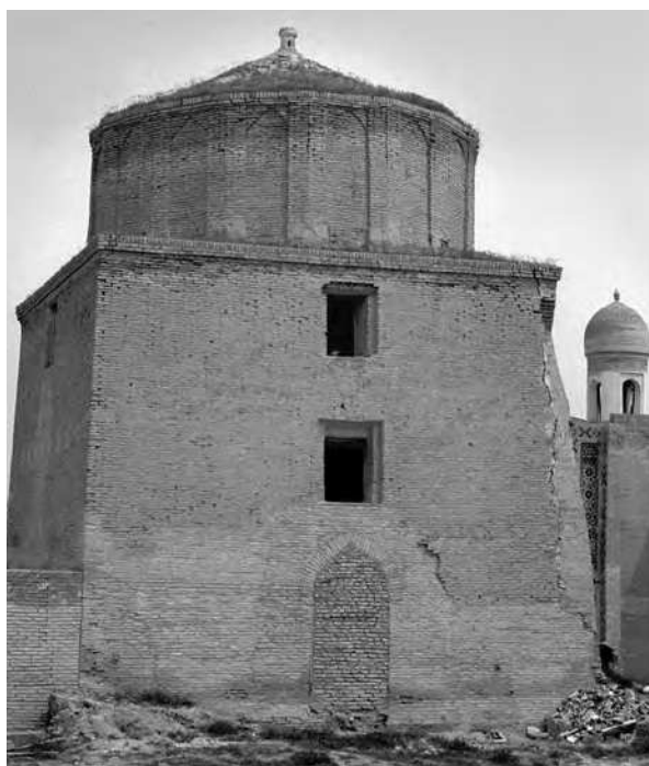
Рис. 141. Мавзолей эмира Бурундука, вид с юго-запада. Фото 1998 г.
