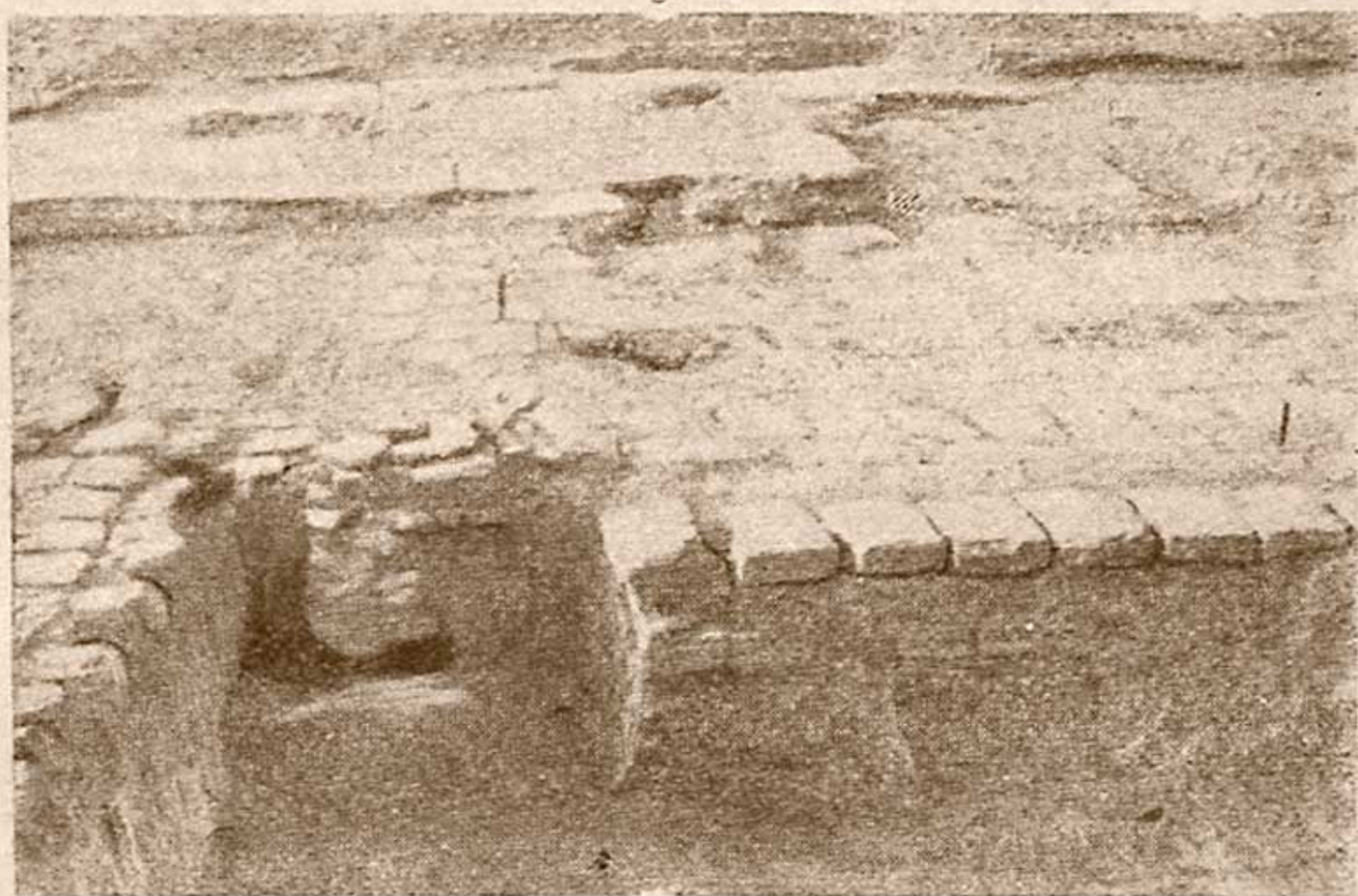
Рис. 8. Водосливное приспособление (слева) и фигурная выкладка из сырцового кирпича.
