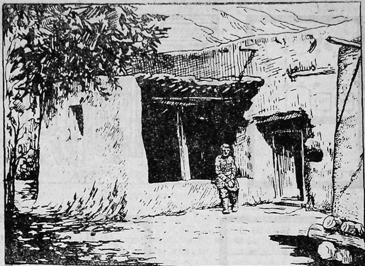
Рис. 42. Дом в к. Пшнхарв, с верандой — пештоқ , прилегающей торцовой стенкой к жилью; справа у двери круглое отверстие деревянного замка-засова — кылафул , рис. с фото 1954 г.
