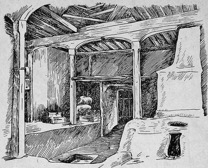
Рис. 8. Печь с дымоходом в старом доме, переделанная из очага, Дарваз, к. Егид, 1954 г.
