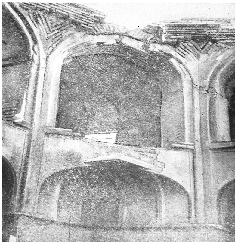
22. Конструкции перекрытий в северо-западной дарехане.
