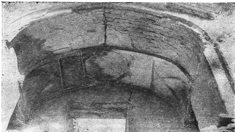
24. Перекрытие ниш северо-западной дарсханы.
