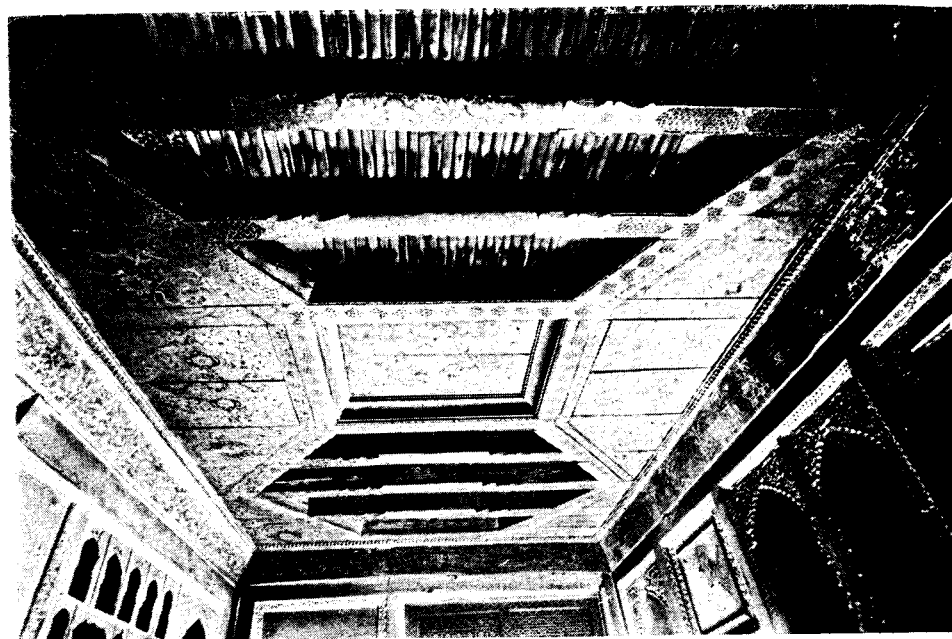
Рис. 89. Потолок дома Ахмаджона в Ташкенте. 1848 год. Сочетание балок, васа и дощатых плоскостей, роспись и резьба
