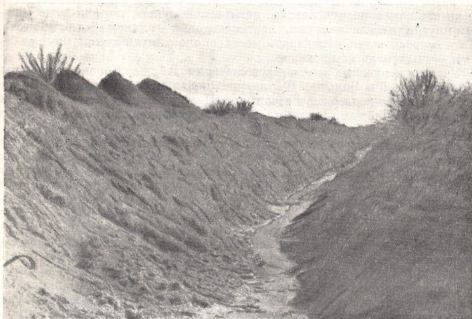
Рис. 13. Коллектор для отвода грунтовых вод.
