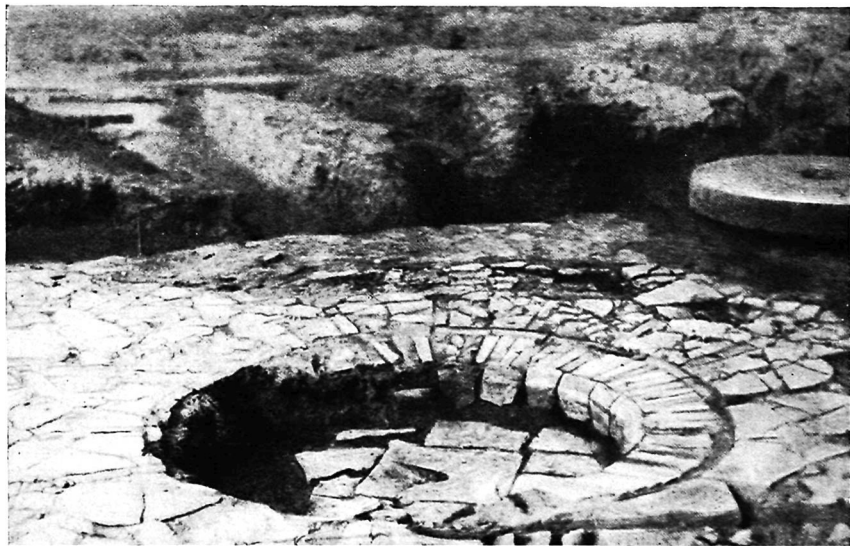
Рис. 38. Поглощающий колодец и закрывавший его жернов
