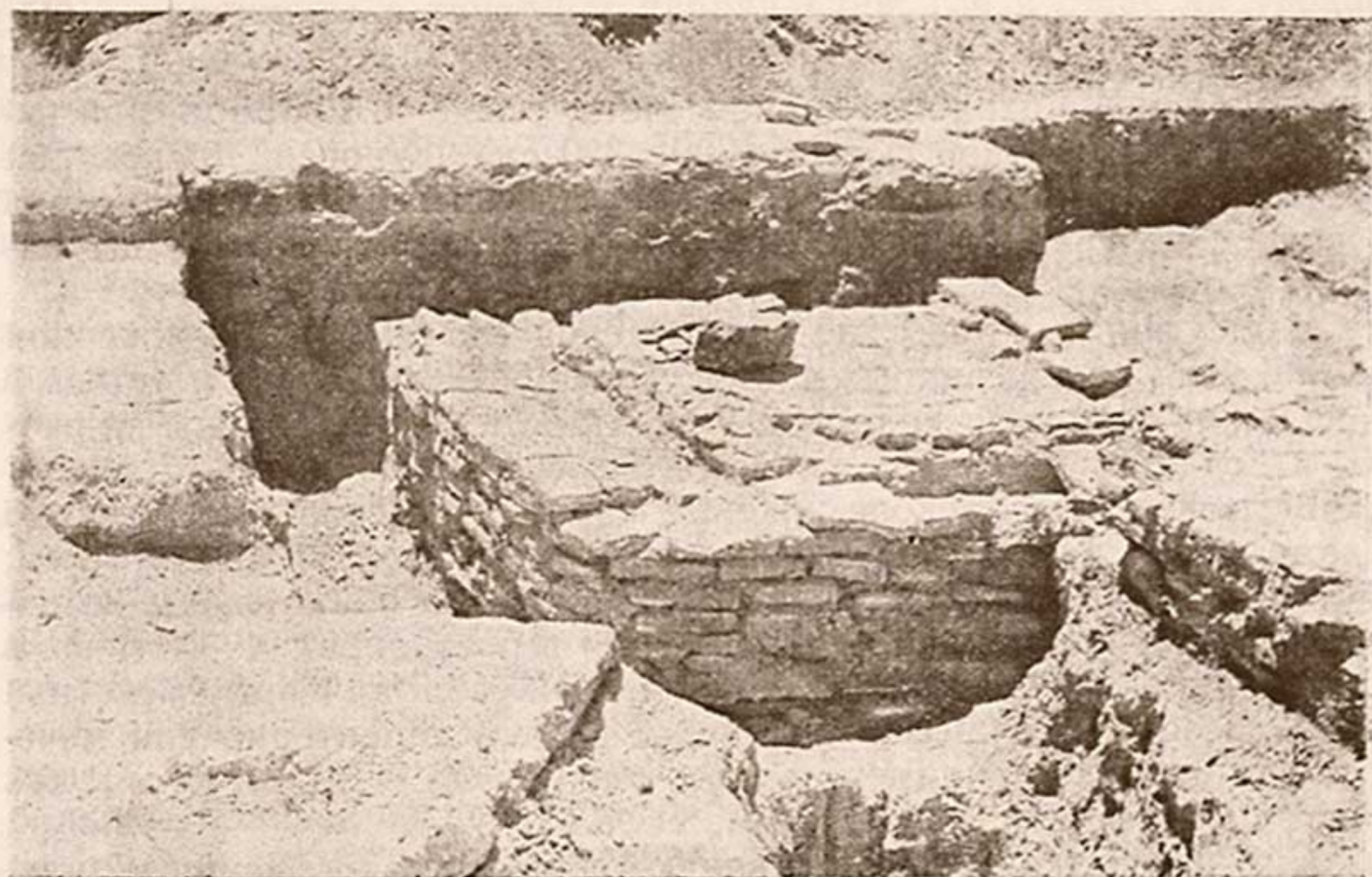
Рис. 2. Основание устоя колонны.
